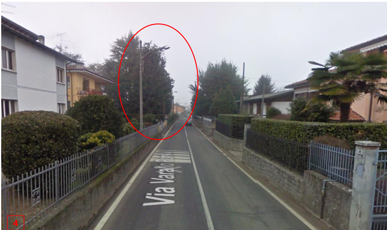
Figura 27. Esempi di illuminazione pubblica non conforme in Via Varallo Pavia. Fonte: Google Street View.
