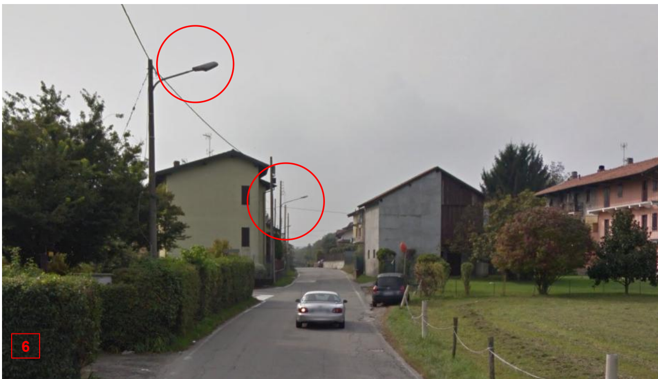
Figura 29. Esempi di illuminazione pubblica non conforme in via Aronco. Fonte: Google Street View.
