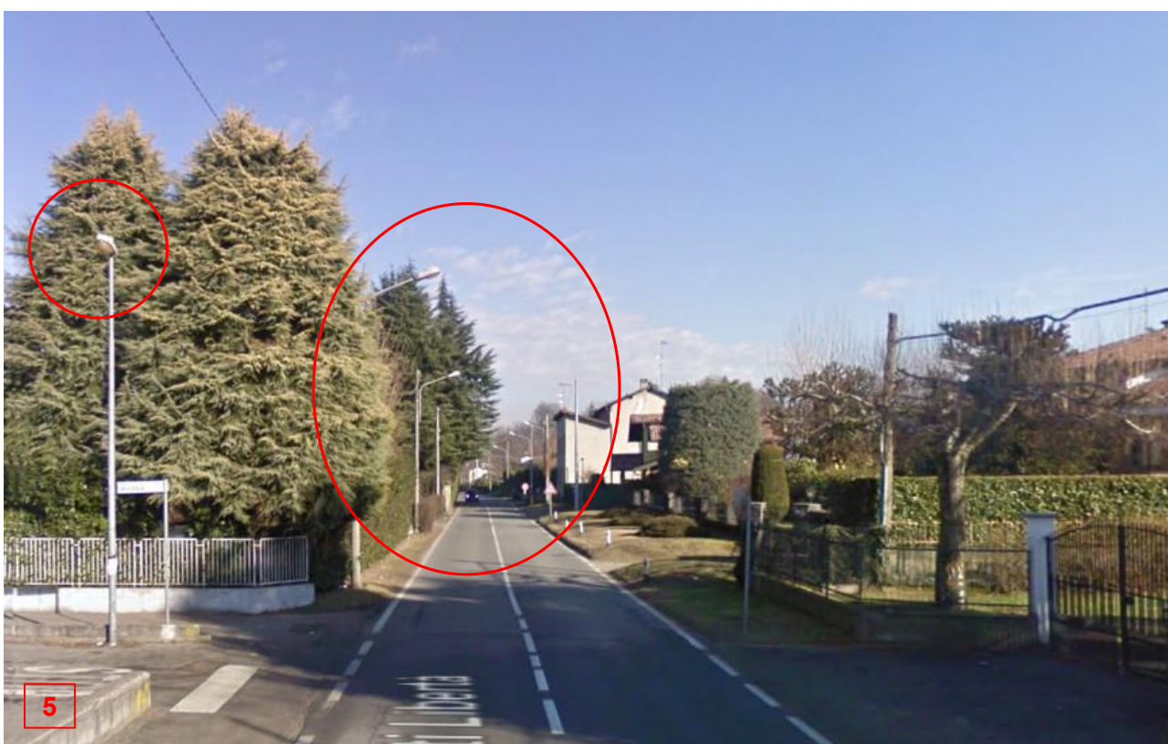
Figura 28. Esempi di illuminazione pubblica non conforme in Via Caduti Libertà. Fonte: Google Street View.
