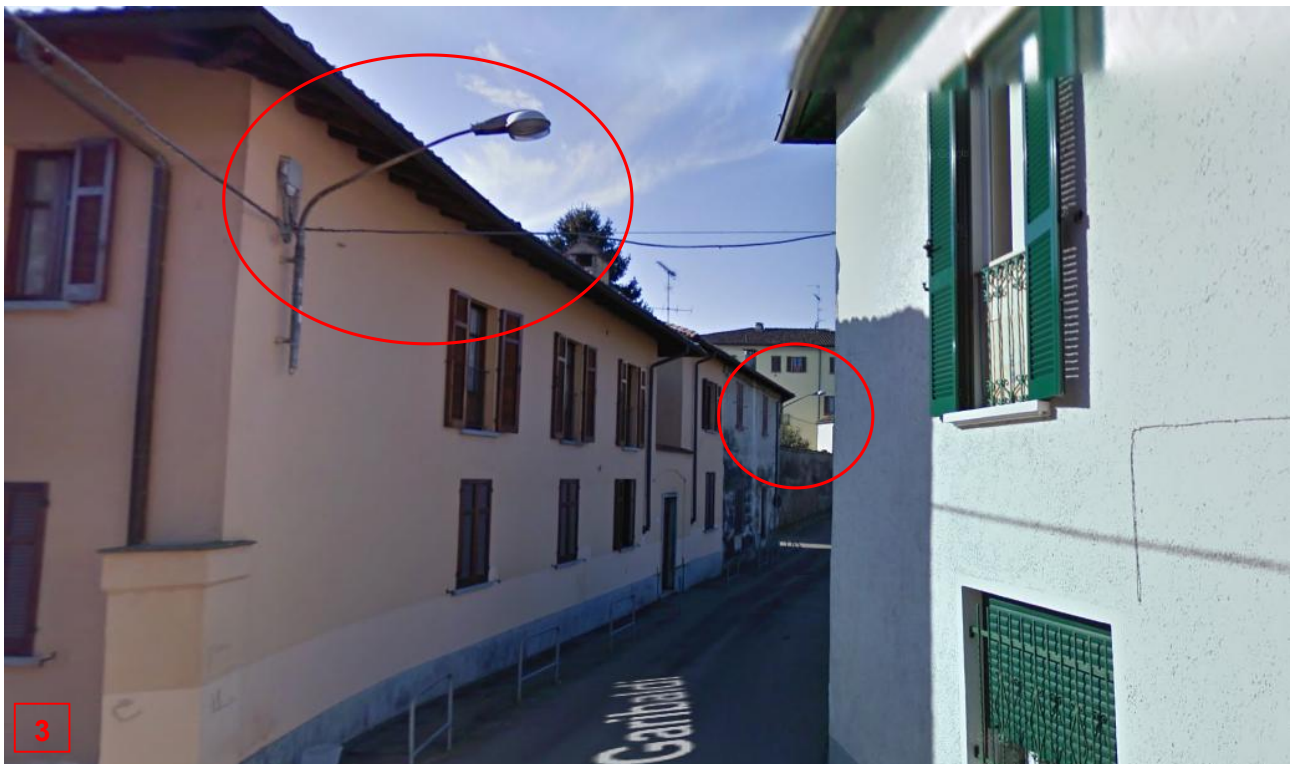
Figura 25. Esempi di illuminazione pubblica non conforme in Vico Garibaldi. Fonte: Google Street View.
