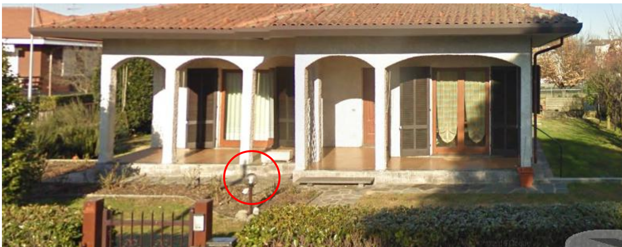
Figura 41. Esempio di illuminazione privata non conforme in via Dante Alighieri. Fonte: Google Maps.
