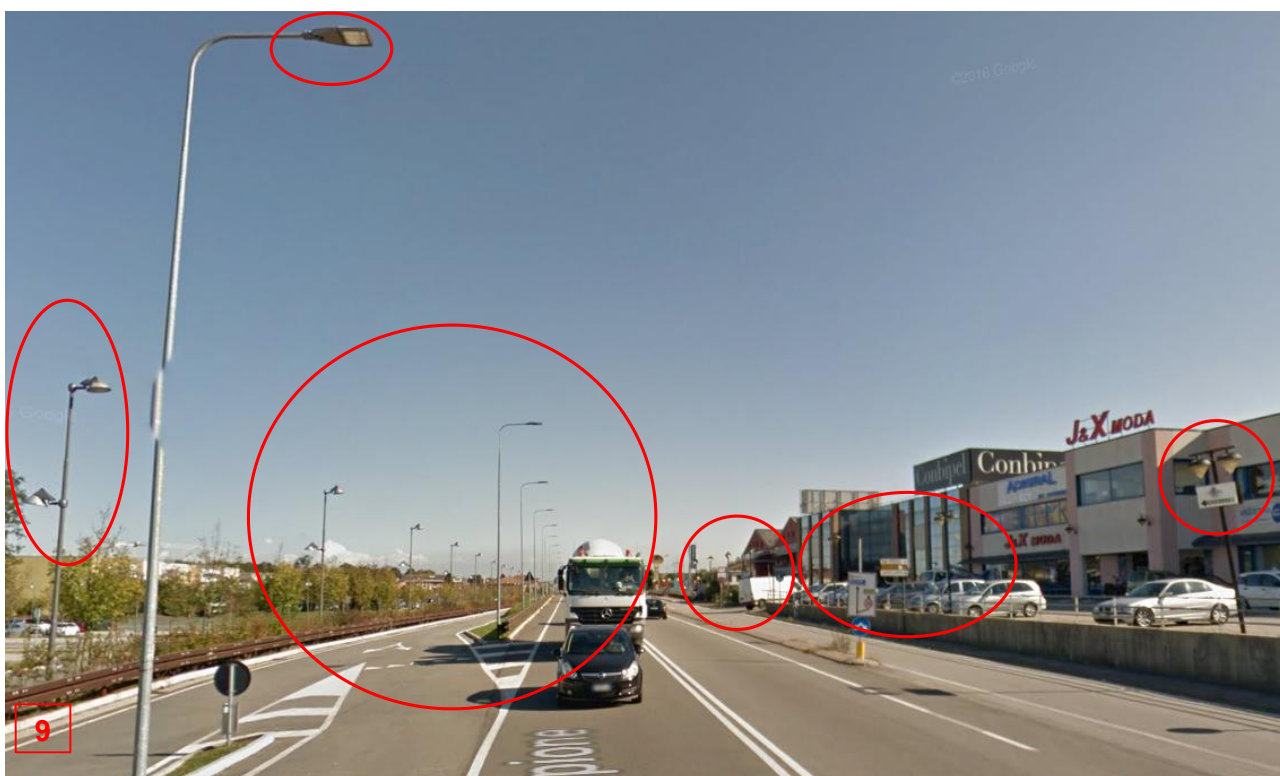
Figura 33. Insediamenti commerciali lungo la SS 33, esempi di illuminazione pubblica conforme e non conforme. Fonte: Google Street View.
