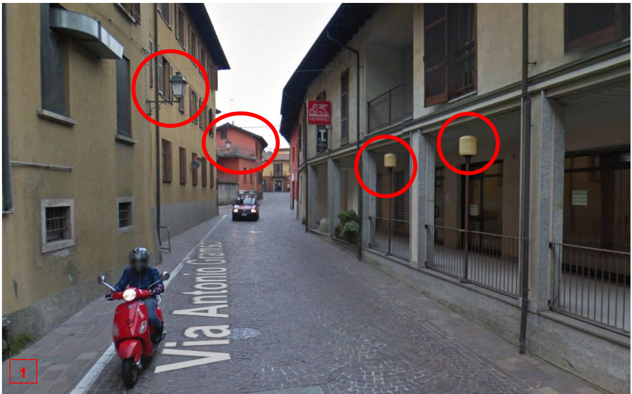
Figura 23. E di illuminazione pubblica non conforme in Via Gramsci. Fonte: Google Street View.
