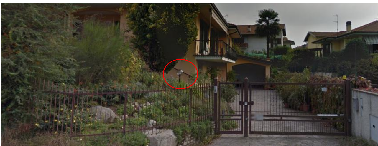
Figura 42. Esempio di illuminazione privata non conforme in via Aronco. Fonte: Google Maps.
